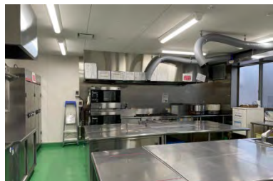
厨房の全体です。 作業時には、こちらで給食サービスの作業を取り組むスペースです。
