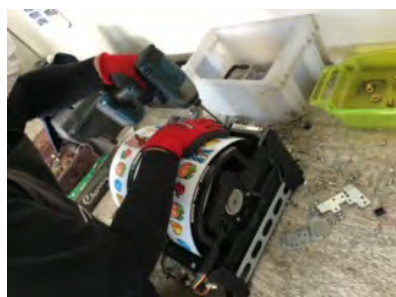
パチンコ・パチスロ解体作業
