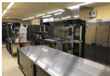
こちらが、厨房の全体になります。 広々とした厨房で、調理ができます。
