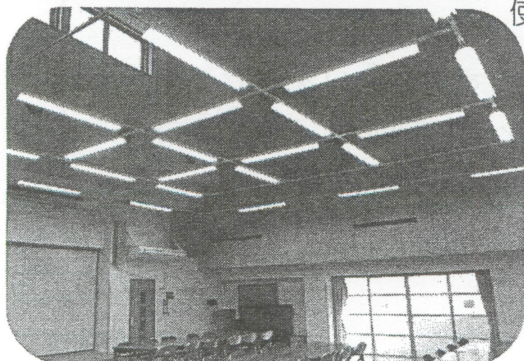
新しいエアコンと LED照明
