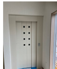
エレベータ有り
