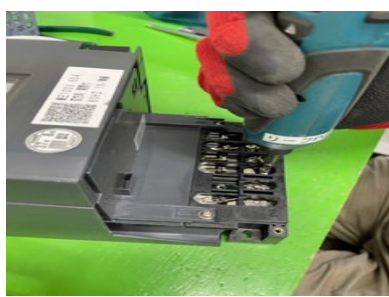
電気メーター解体作業
